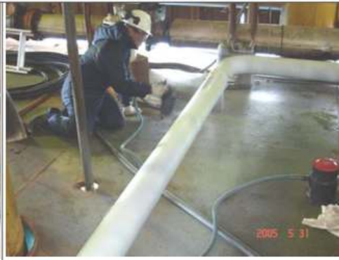
Final section applying primer
